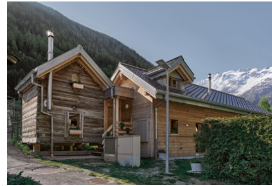
Der alte Kornspeicher (links) wurde gekonnt mit dem neuen Teil verbunden.
